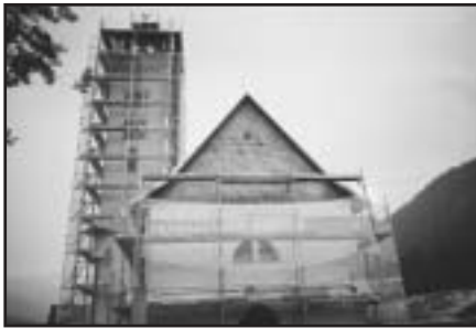
Als letztes wurde die Fassade beim dreieckigen Ausflughoch (Bildmitte) neu verputzt. Das Fenster wurde auf der Innenseite aufgeraut, damit die Hufeisennasen beim «Ausflug» in gewohnter Weise nach vorne hangeln können.
