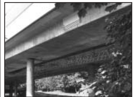
Am Steg des Brückenhohlkörpers wurden im Zuge der Sanierung 18 Fledermauskästen montiert. Blick von der Manessestrasse aus. Die Kästen sind aus Fichtenholz, je 3 m lang und 1.20 m hoch. Sie weisen drei Kompartimente auf mit Spaltenweiten von 15 mm, 25 mm bzw. 35 mm. So finden kleine und grosse Fledermausarten Unterschlupf.
