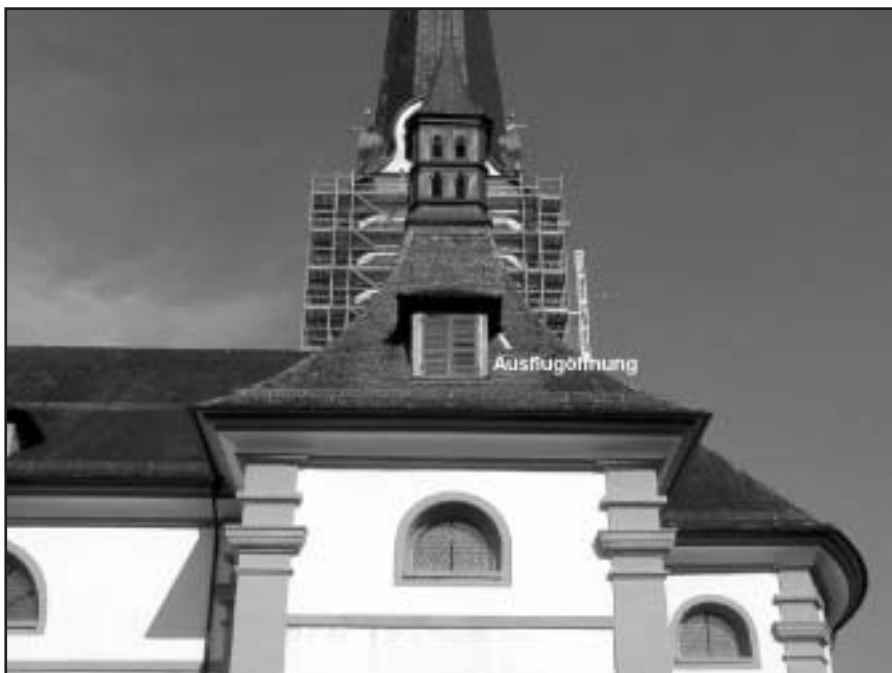
Die Ausflugöffnung der Grossen Mausohren in der Pfarrkirche in Malters wird nach der erfolgreichen Dachrenovation so rege benützt wie seit Jahrzehnten nicht mehr.
